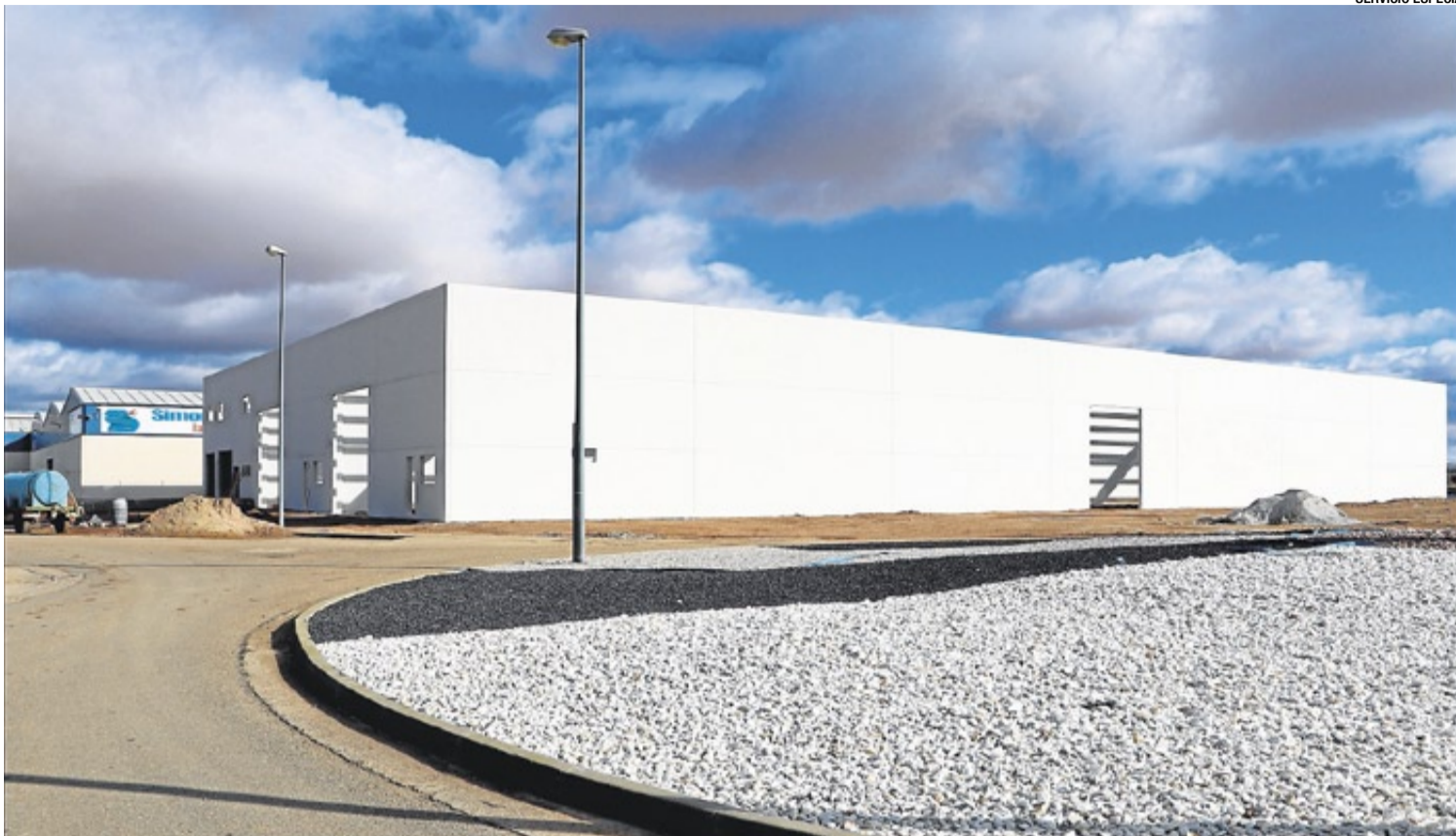
Infraestructuras en perfectas condiciones. Rotonda de acceso al sector agroindustrial del polígono de Alfamén
